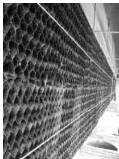
รูปที่ 7.3-13 ลักษณะการจัดเรียงของตัวกลางพลาสติกภายในระบบกำจัดกลิ่น
