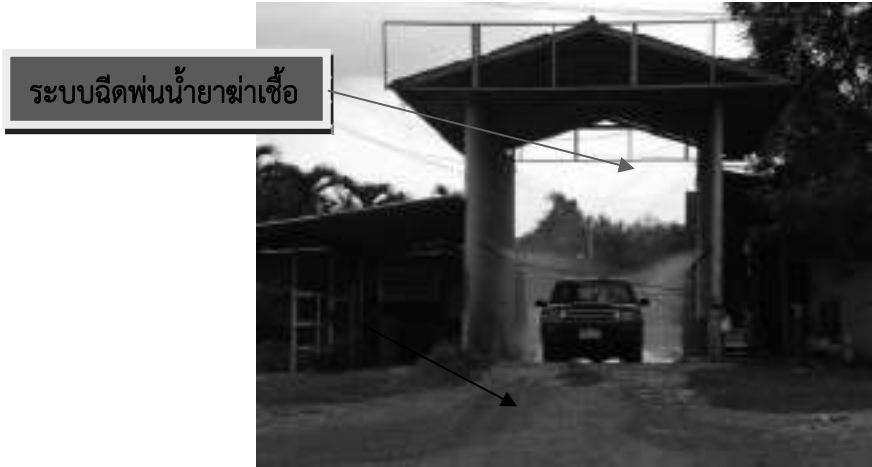
รูปที่ 6.2-4 การฉีดพ่นน้ำยาฆ่าเชื้อโรคนยานพาหนะที่เข้าภายในฟาร์ม
