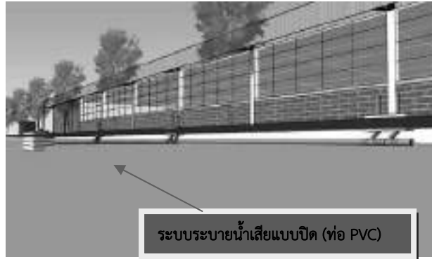
รูปที่ 6.1-6 รางระบายน้ำเสียแบบระบบปิด (ท่อ PVC)
