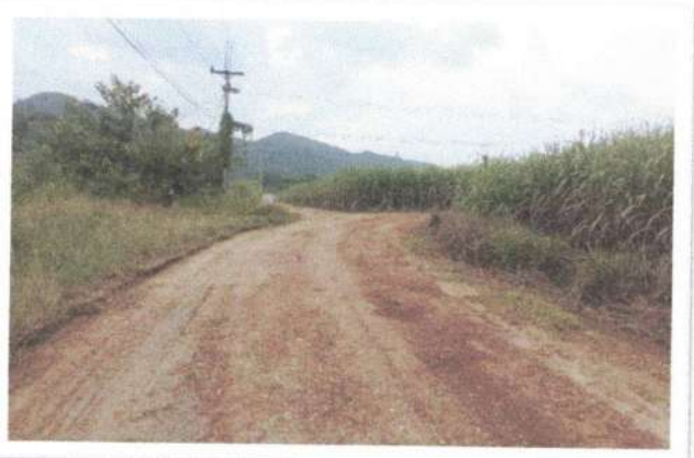
โครงการปรับปรุงซ่อมแซมถนนลูกรังภายในหมู่บ้าน หมู่ที่ ๖ บ้านกระพริยสองข้าม
