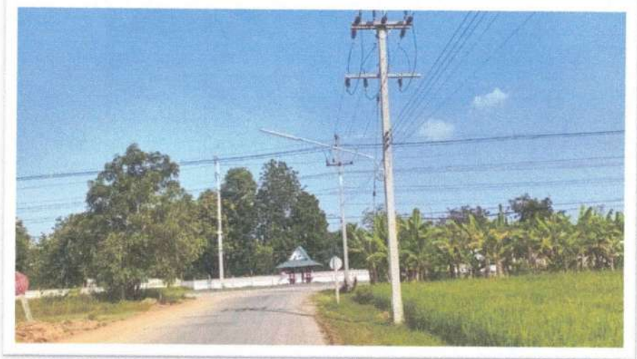
โครงการอุดหนุนงานขยายเขตจำหน่ายไฟฟ้าแรงต่ำพร้อมไฟส่องสว่าง บ้านหนองไม้เอื้อย หมู่ที่ ๒
